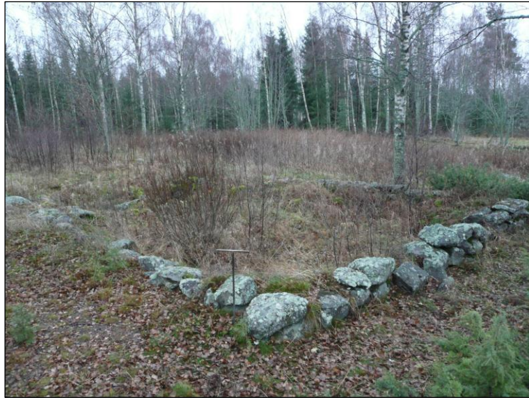
Tien eteläpuolista rakennuksen perustaa
